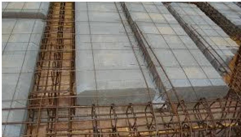
*Forjado cubierta: unidireccional semiviguetas armadas con zapatilla*
